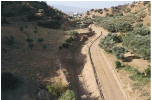
Topandağ Dere Yatağı ıslah çalışmaları
