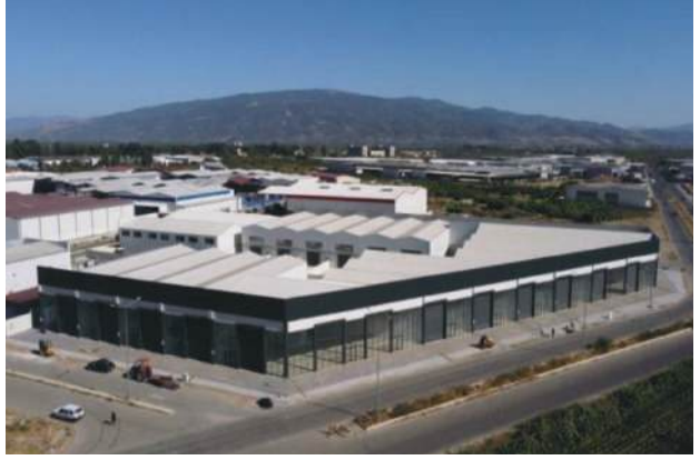
Ticaret Odası dükkanları önü Kaldırım Düzenleme
