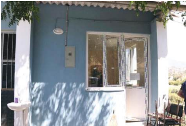
Kardeşköy Muhtarlık Binası yenilendi
