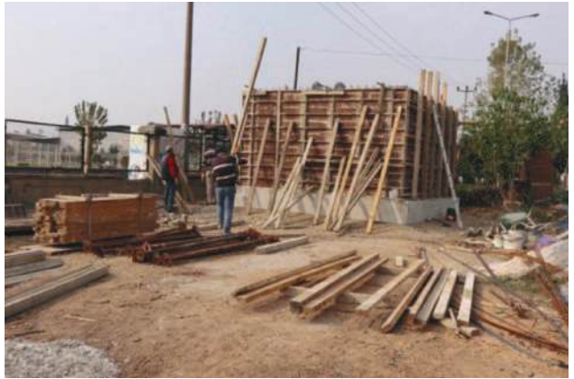
Şantiye Yanı 40 tonluk iyi su deposu yapımı
