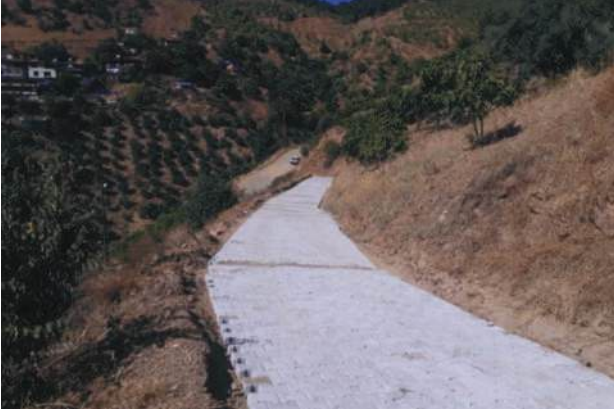
Ketenova Mah. Yol Düzenlemesi
