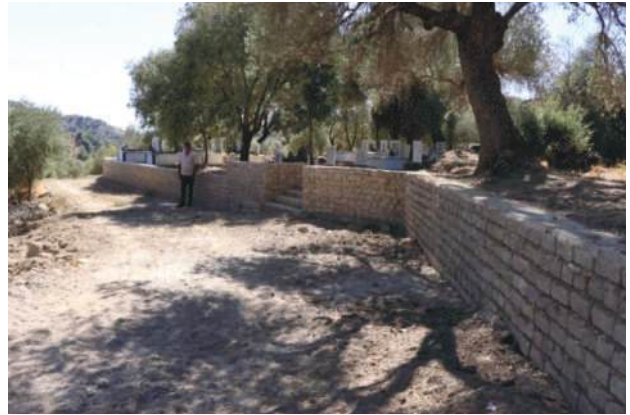
Gedik Mahallesi Mezarlık etrafı istinat duvarı
