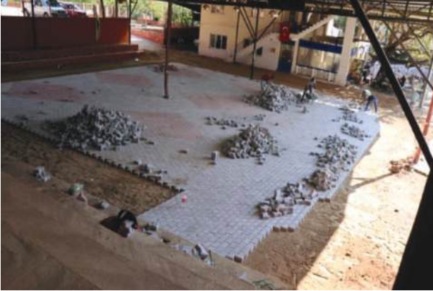
Aksu Mahallesi Sosyal Çatı altı Düzenlemesi
