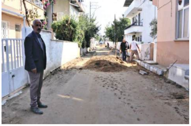
Yeşil Mah. 1143 Sok. Yol düzenlemesi
